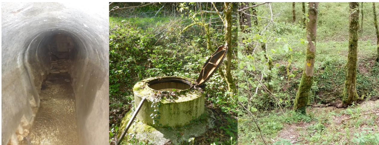
Figure 4 : Photo de la galerie (à gauche), du tampon d'accès à la galerie (au milieu) et du ruisseau, à sec (à droite).
